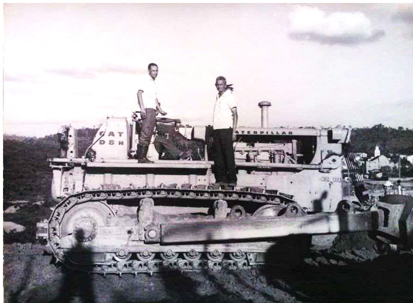
Imagem 2. Escavações iniciais do Ginásio de Ubatã (1965)
